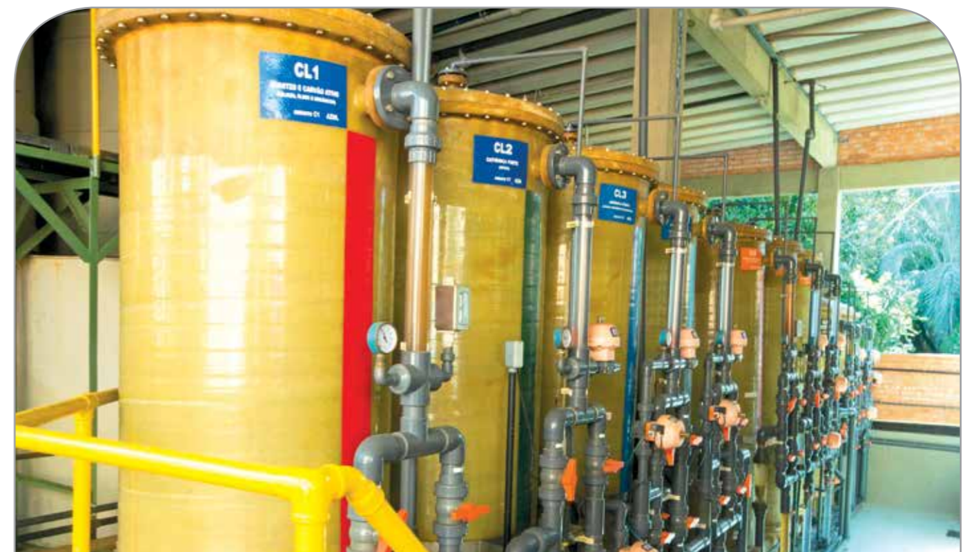
Estação de Tratamento das águas de lavagem da galvanoplastia em circuito fechado com processo de resina de troca iônica.
