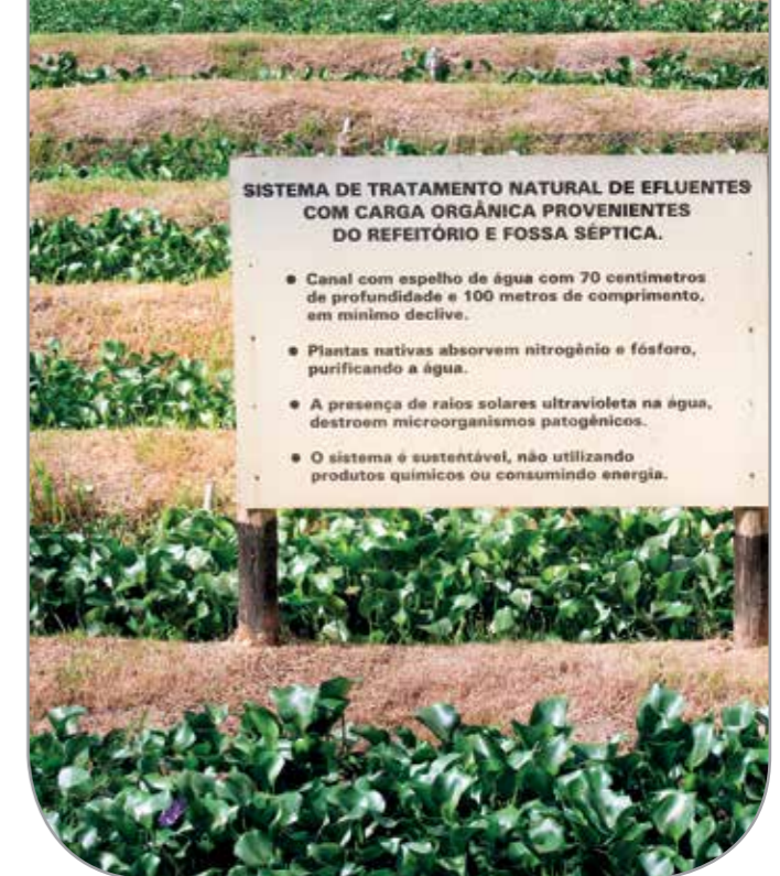
Sistema de Tratamento Natural de Efluentes com carga orgânica provenientes do refeitório e fossa séptica.
