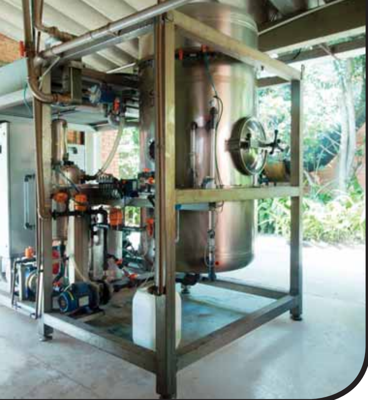
Evaporador a Vácuo para eliminação dos contaminantes químicos e desmineralização de efluente.
