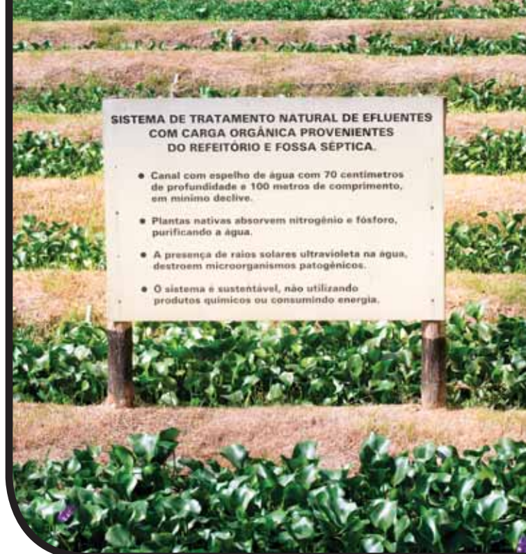
Sistema de Tratamento Natural de Efluentes com carga orgânica provenientes do refeitório e fossa séptica.
